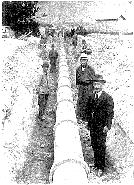
三村用水ヒューム管敷設
