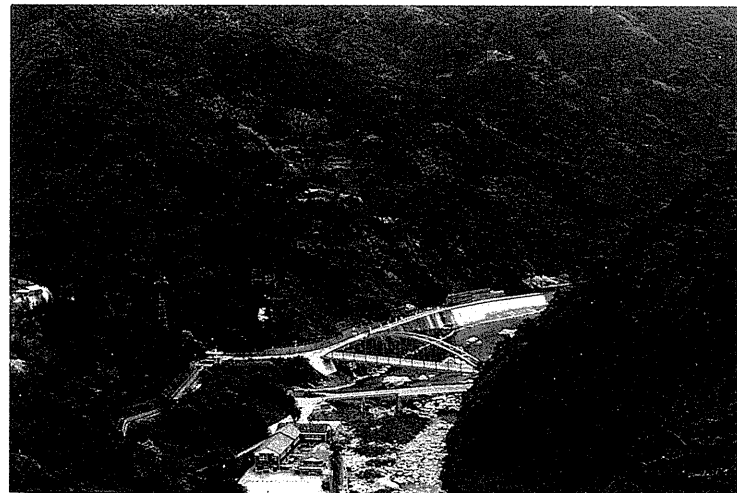
写真1-1 昭和53年度前期の柳谷村崩壊地点の全景 (松山側から高知側を望む)
