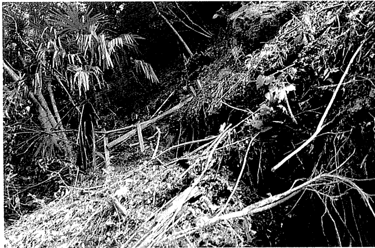
写真3-5 昭和54年7月15日、高知側斜面に発生した開口クラック (高知側から松山側に向かって写す)
