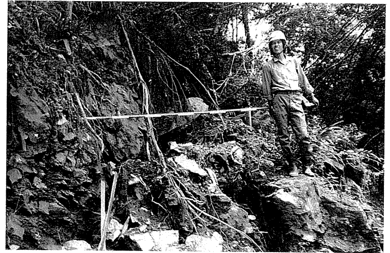
写真3-6 昭和54年7月15日、高知側斜面に発生した開口クラック (松山側から高知側に向かって写す)
