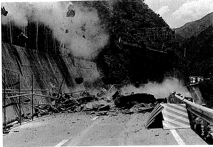
写真3-8 昭和54年7月20日、午前9時30分、高知側斜面の岩塊が路面上に落下中
