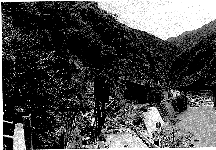
写真3-9 昭和54年7月20日午前9時30分、3,000m 2 に及ぶ崩落物が路面を覆う
