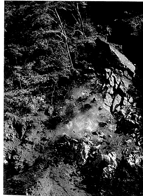
写真3-6 昭和54年7月15日、高知側斜面に発生した開口クラック (松山側から高知側に向かって写す)
