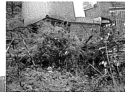
砂防施設が土砂を捕捉 (上から)
