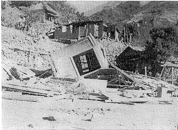
ルース台風による被害 石鎚村戸石分校
