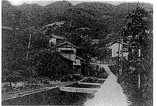
泊小学校北側を流れる新川、ここも水害時には土砂の津波が寄せた。(吉海町大字泊)
