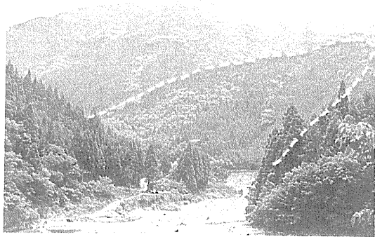
保勢崩壊現場（点線内）
