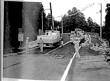
復旧工事状況（起点側より）
