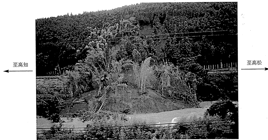
①崩壊地全景
