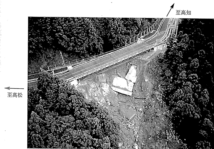
応急組立橋設置状況
