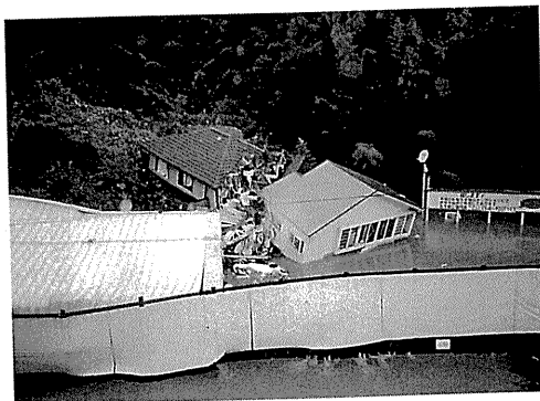
家屋倒壊状況
