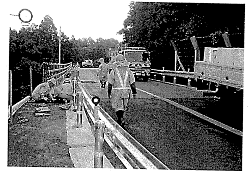
復旧工事状況（終点側より）
