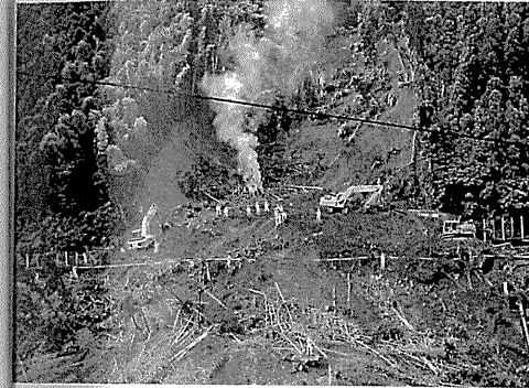
復旧工事状況
