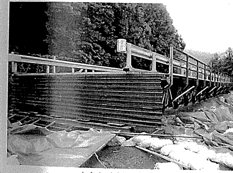
応急組立橋設置状況
