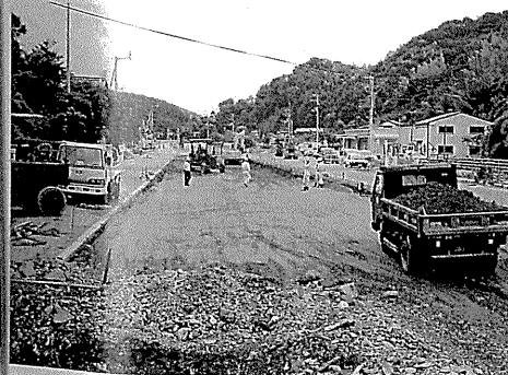
盛土工施工状況（起点側より）
