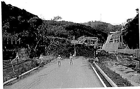
被災状況（終点側より）
