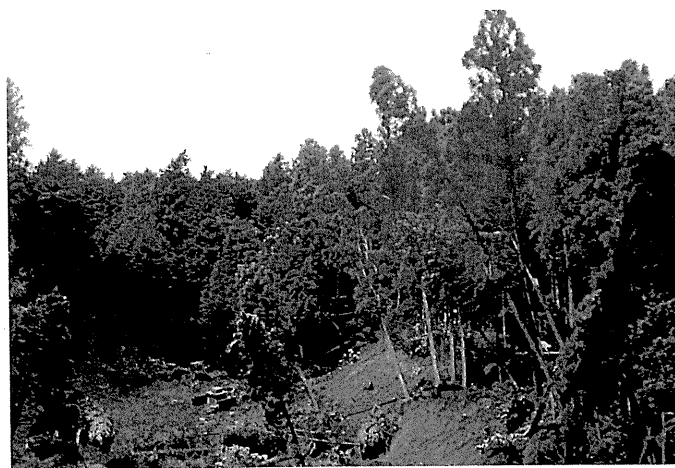
②崩壊源頭部
