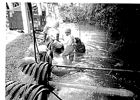
仮排水管施工状況（起点側より）
