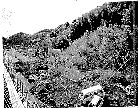
被災状況①（起点側より）
