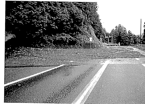
③起点側の小沢より発生した土石流による路面への流出状況
