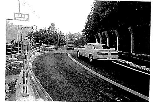
一車線確保状況
