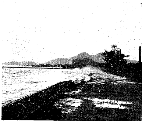
松山市三津浜町(キジャ颱風時に於る縣道郡中—三津濱線の被害状況)
