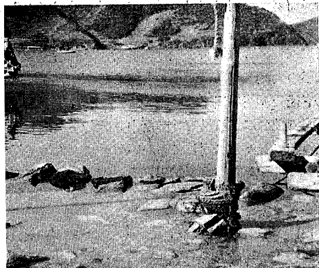
西宇和郡川之石町(沈下後の海岸一帯 に護岸天端すれすれまで潮位が上る)
