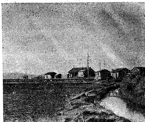
小松島町に於けるサンドポンプによる耕地客土工事
