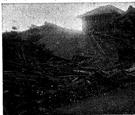
坂出市林田町(地震の爲に倒壊した家屋)
