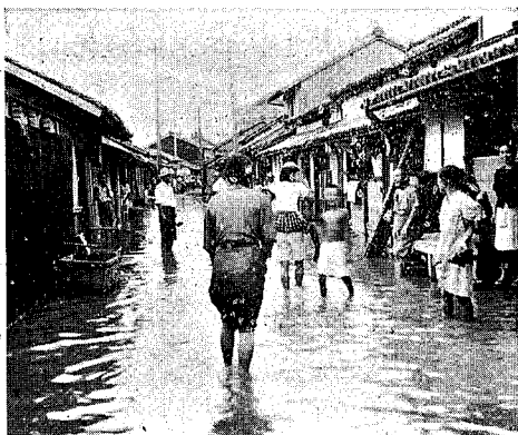
宇摩郡川之江町(キジャ颱風時の宇中須町の浸水状況)
