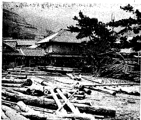
喜多郡出海村(キジャ颱風後の状況)
