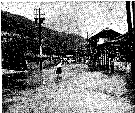
(左) 小豆郡淵崎村(縣道土庄一坂手線の海水浸入状況—昭25.9.13)
