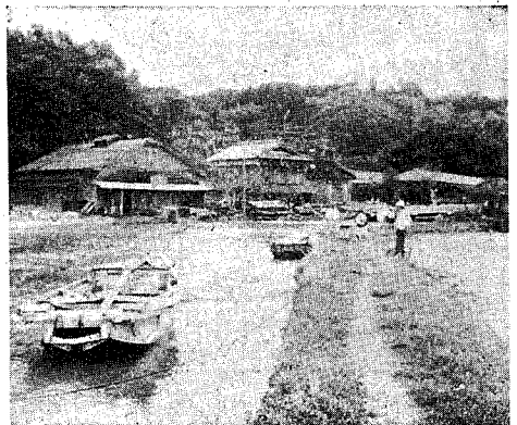
堤防決潰により水田へ漁船の避難している甲浦町
