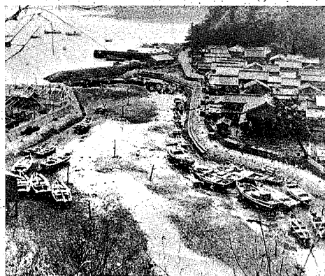
災害復舊工事として根堅めを完成し た木岐浦港
