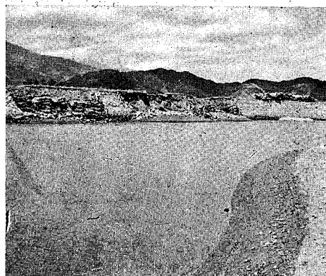
宇摩郡燕崎村(海岸堤破壊状況—キシヤ颱風直後)
