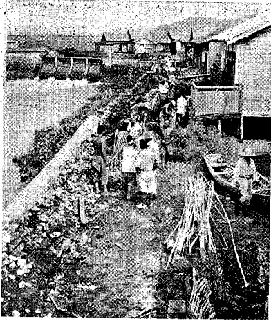
伊豫郡松前町 (キジヤ颱風後の 海岸堤復舊状況)
