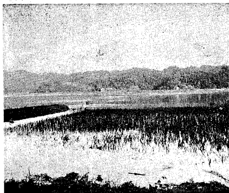
ジェーン颱風の時決潰した橘町海岸堤防
