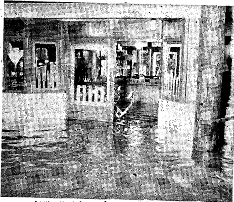
伊豫郡中町 (キジヤ颱風時の町内 浸水状況)
