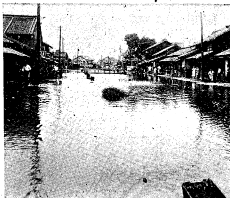
温泉郡北條町 (明星川筋の氾濫状況)
