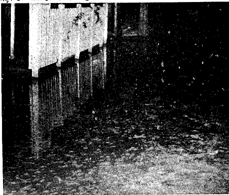
(左) 小豆郡淵崎村(縣道土庄一坂手線の高潮浸入状況 昭25.9.13)
