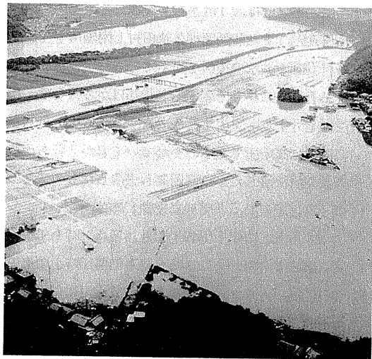
写3-1-1 破堤した用石堤防と氾濫状況
