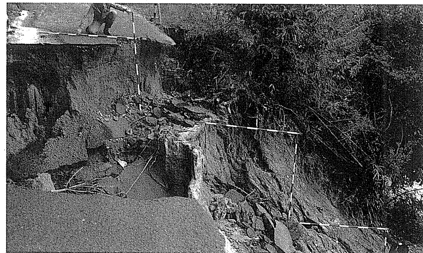
町道三条鹿庭線 (鹿庭三区)
