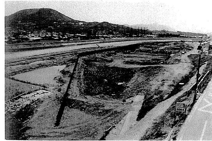
土器川潮止堰建設事業に着手（昭和52年4月）
