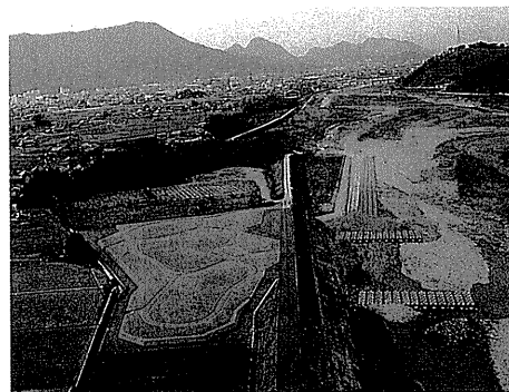
平成3年12月吉野桜づつみモデル事業に着手。 平成5年3月、1期工事完了（満濃町吉野）
