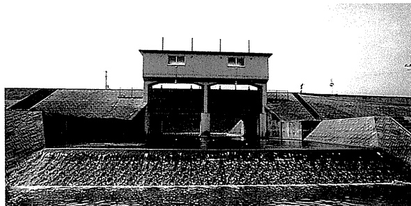
完成した古子川樋門（昭和57年8月）
