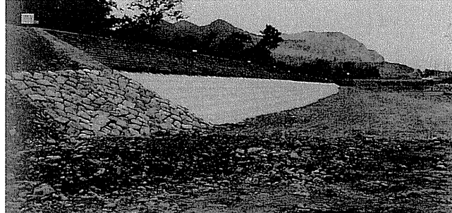
土器川成願寺堤防工事（昭和58年）
