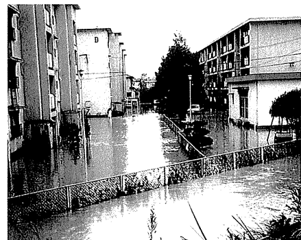
昭和62年10月台風19号による内水被害状況
