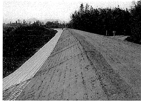
完成した土器川堤防（丸亀市垂水町地区）（昭和57年12月）
