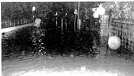
平成2年9月19日の台風19号による内水被害状況（丸亀市）
