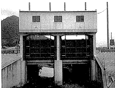
赤山川樋門完成（昭和63年11月30日）
