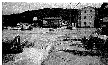
平成10年9月洪水による支川片地川流域のはん濫（香美市神母ノ木地先）……②
