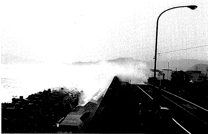
□平成16年8月 台風16号仁ノ海岸越波状況
