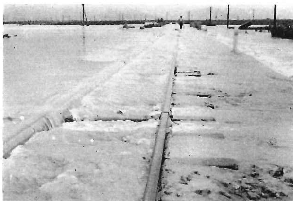
S. 25.9 (キジア台風) 国鉄予讃線の溢流 状況=若宮にて
