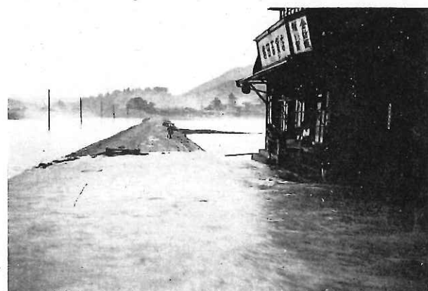
S. 35. 6 梅雨前線による西大洲の浸水状況
