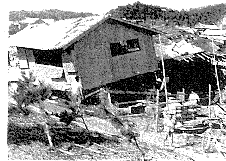
倒壊した民家 (土佐市)
