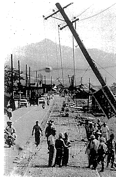
バタバタ倒れた電柱（南国市）
