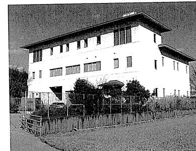
⑨ 枝川雨水ポンプ場
