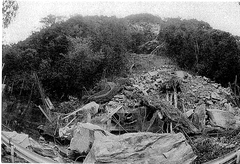
国道32号 三好郡山城町大歩危 平成5年10月9日（被災状況）
