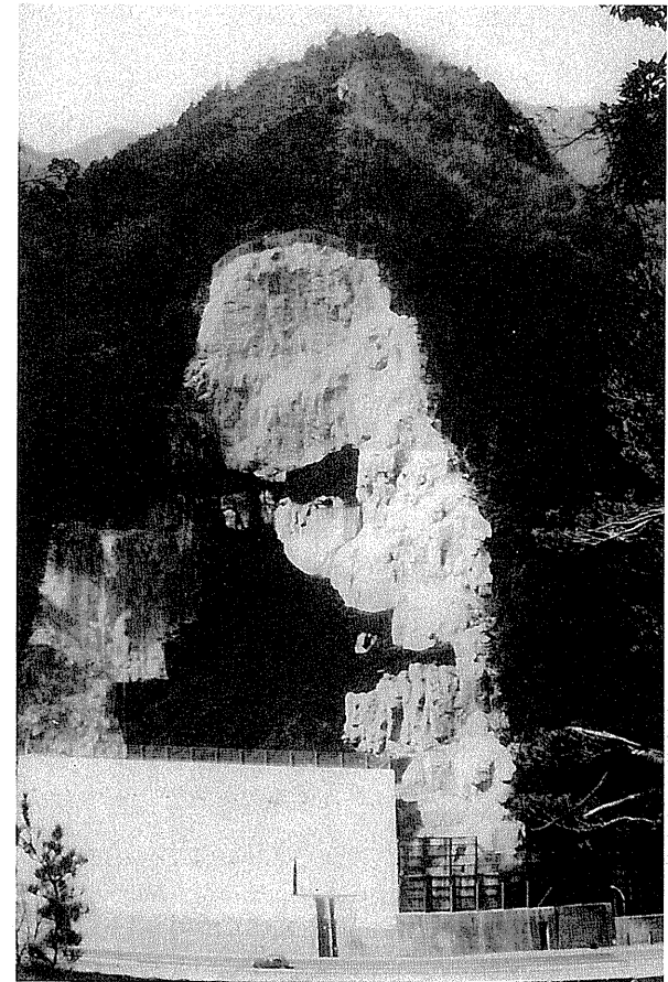
国道32号 三好郡山城町大歩危（完成）
