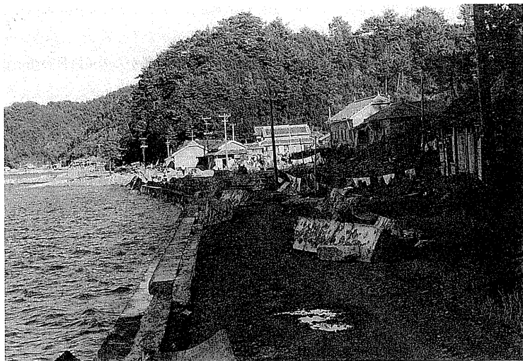
国道11号 鳴門市北灘町大浦 昭和36年第2室戸台風
