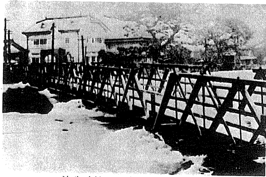
流失寸前の厄除橋(昭6.9.26)
