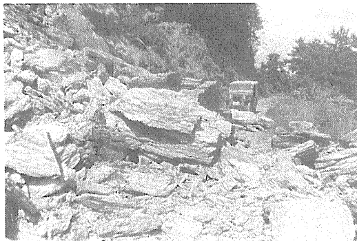
昭和51年台風17号により山くずれて埋った道路
