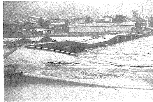
中央部分で折れた長橋（昭和50年台風5号による）
