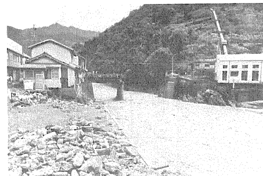
昭和50年台風5号により流失した第1吉良谷橋
