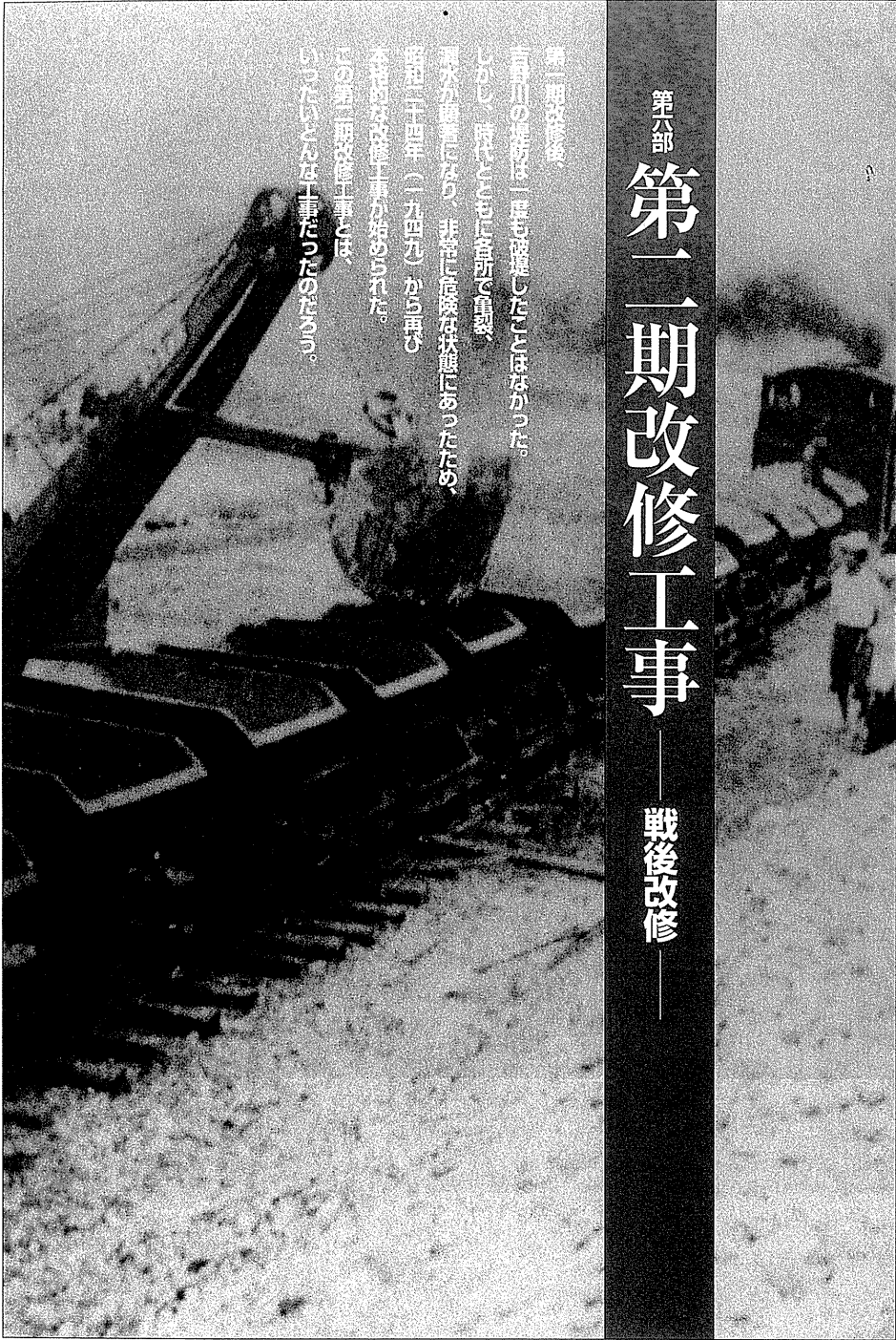
直営時代の建設機械 パワーショベルと鍋トロ（30年代前半）
