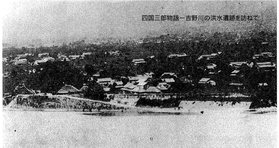
第一期吉野川改修工事前の様子 第一期改修により当時3,000人、500戸の家屋移転に伴い、遊水地化を図った善入寺島
