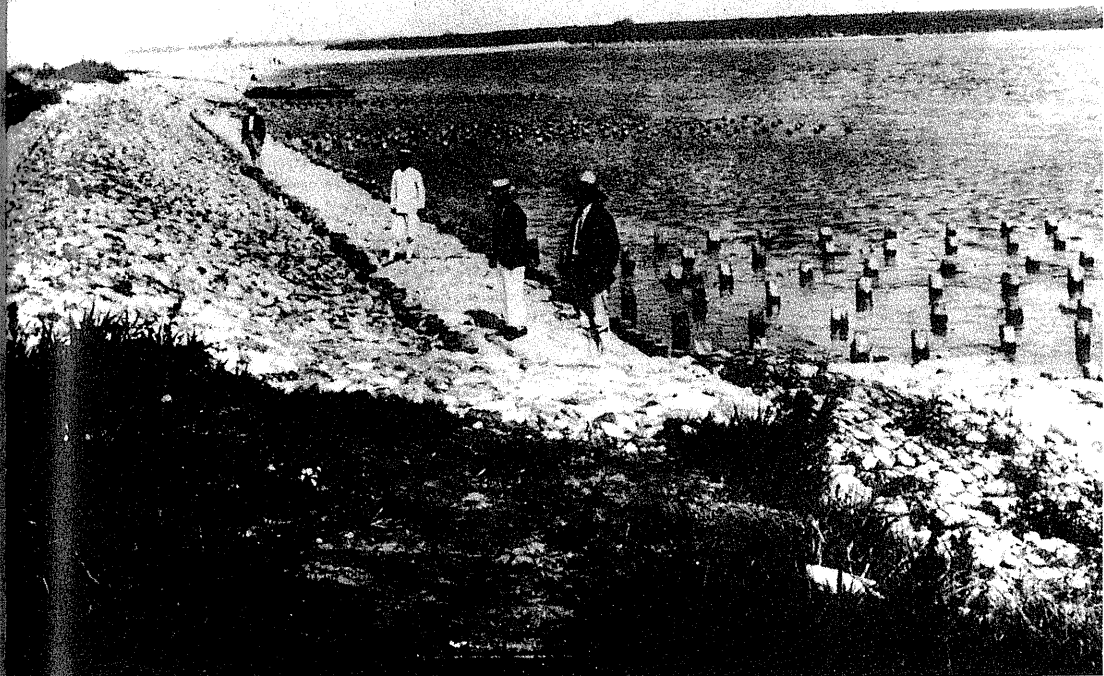
昭和11年徳島県施工によるケレップ水制
