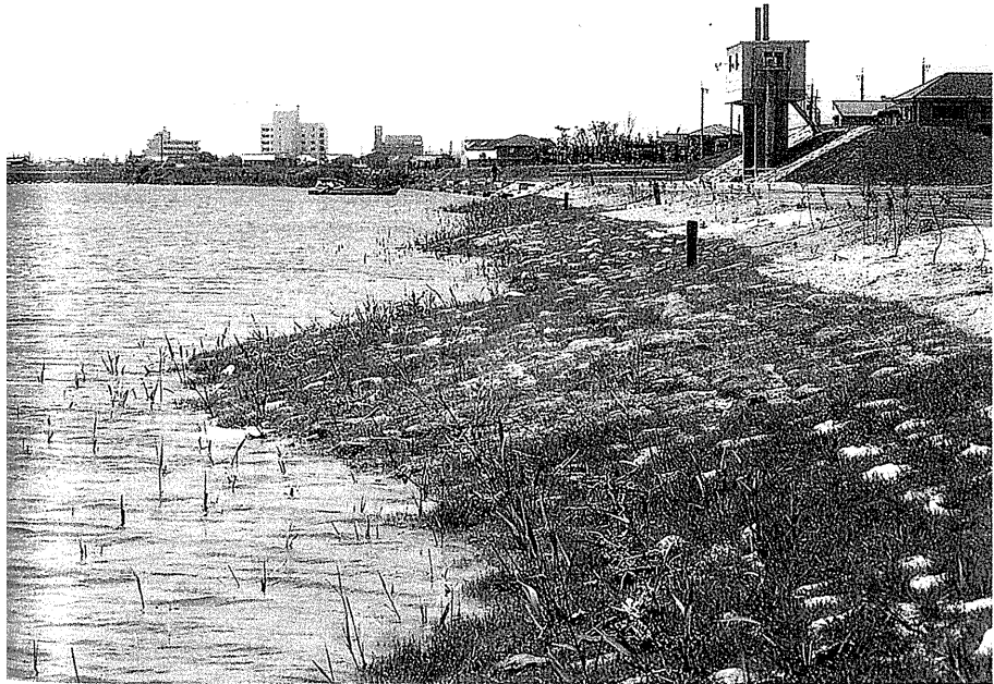
旧吉野川の低水護岸工事(完成後3か月)
