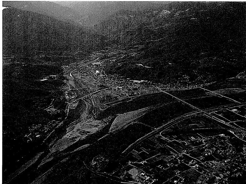
岩津上流の改修工事
