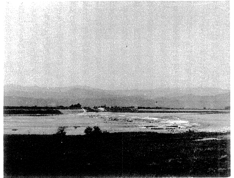
第十堰の現状（北岸より南を望む、右手は西堰、左右の水位が違うところに注意）
