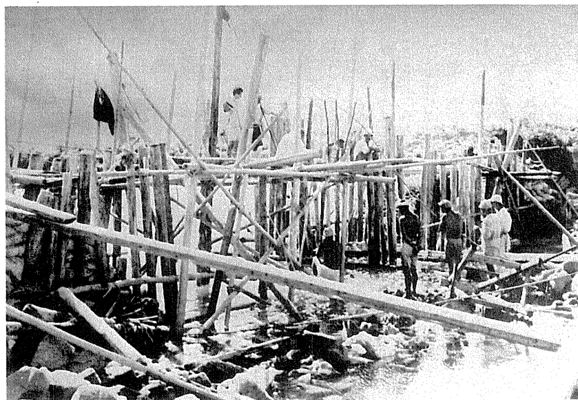
土のうを積み、潜水夫も動員しての堤防復旧作業（三ツ石塩田）
