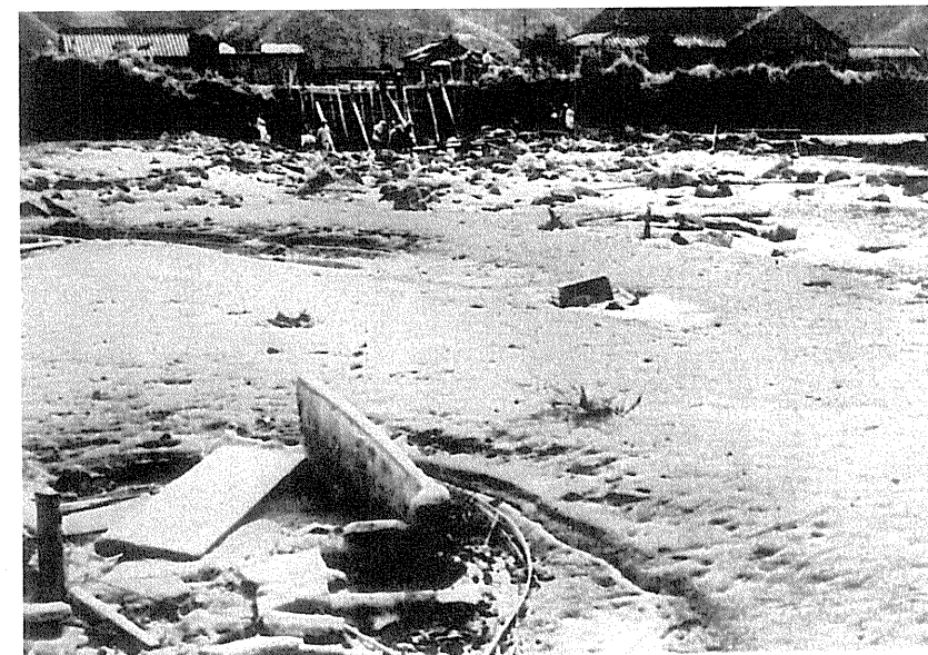
室戸台風による堤防欠壊のため、床面はえぐられて沼井台は跡形もなく、堤防の積石が散乱した無惨な塩田（㊦三ツ石塩田 ㊦高島塩田）
