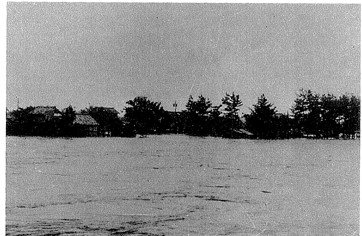
岡川 富岡橋付近 富岡橋より下流を望む
