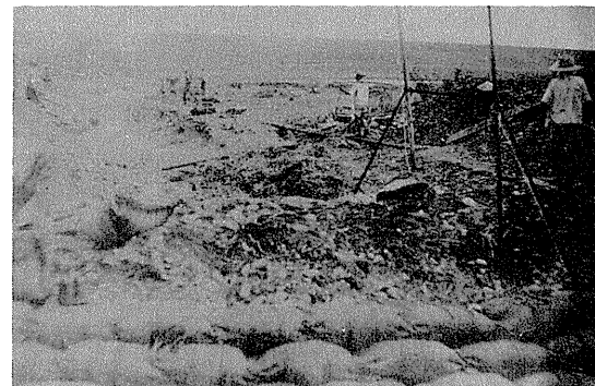
中原 那賀川右岸堤防応急施工
