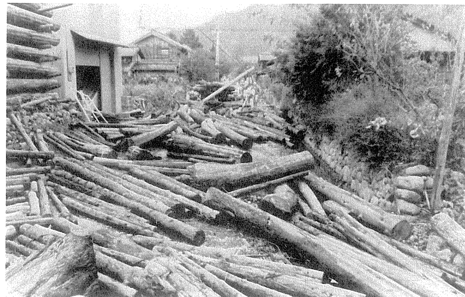
昭和46年 8月 洪水の爪跡 潜水橋へ行く馬場三叉路より西を望む。
