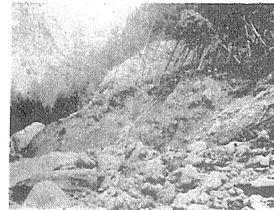
板挾地に被害
