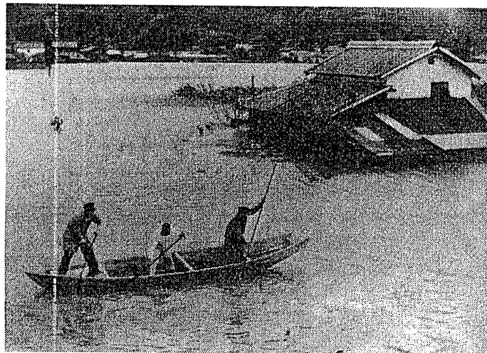
写真 2.2.5 被害状況(下流の内水)
