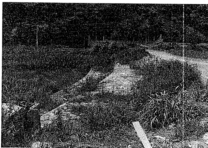
写真 2.2.1 デ・レーケの砂防堰堤
