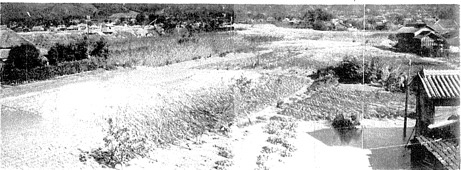
九頭宇谷川左岸堤防決壊現場の惨状
