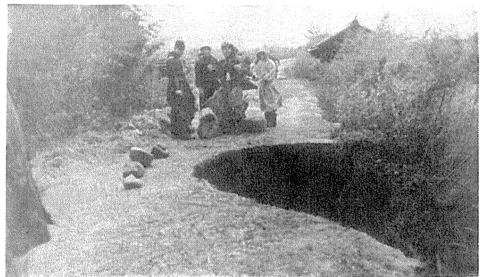
宮川内谷川右岸の決壊 第二室戸台風(昭36.9.16)
