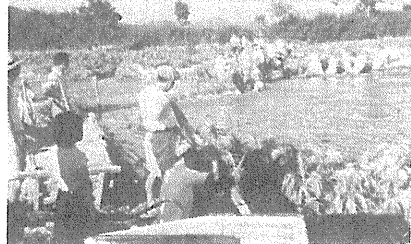
▲原市姥御前線の橋の復旧工事
