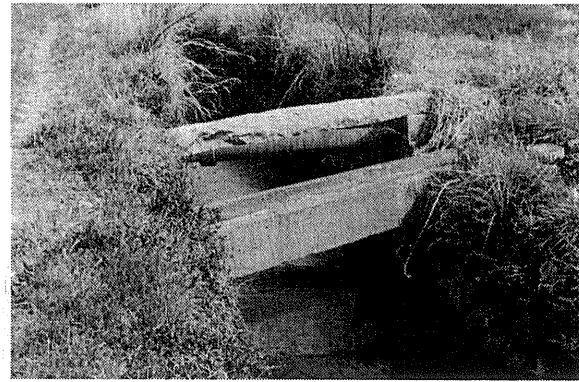
第26図 市之井手（下の水路）と小樋井手（てまえのコンクリートの掛樋） （砥部町八倉）
