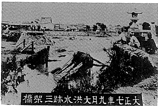
1918年9月の大洪水で流失した三架橋
