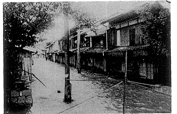
昭和18年7月城辺町中心街の濁流
