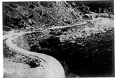
写真73 昭和29年台風5号で寸断された通学道(魚神山)
