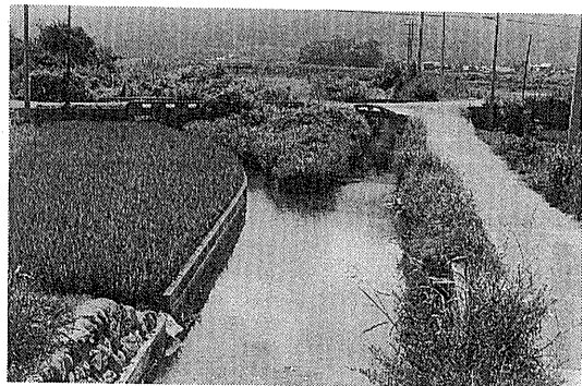
柳原泉と田窪・牛淵井堰水路(見奈良)
