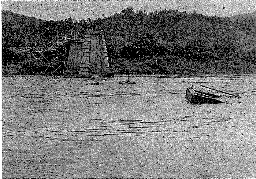
昭和20年枕崎台風の洪水状況
