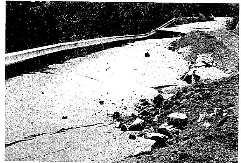
県道小豆島循環線（内海町藤崎付近）
