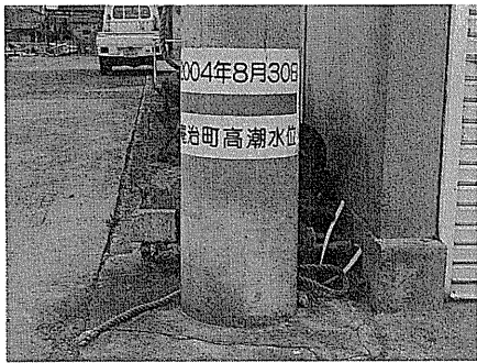
電柱に表示の高潮水位
