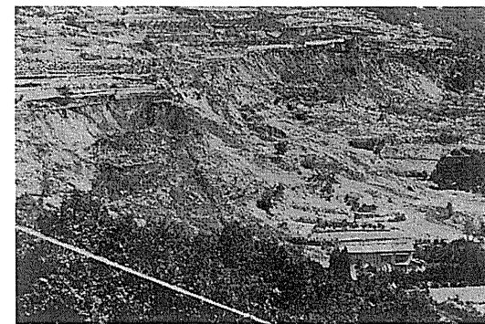
崩落した肥土山地すべり地帯の一部
