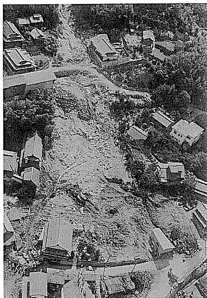
土石流被害状況
