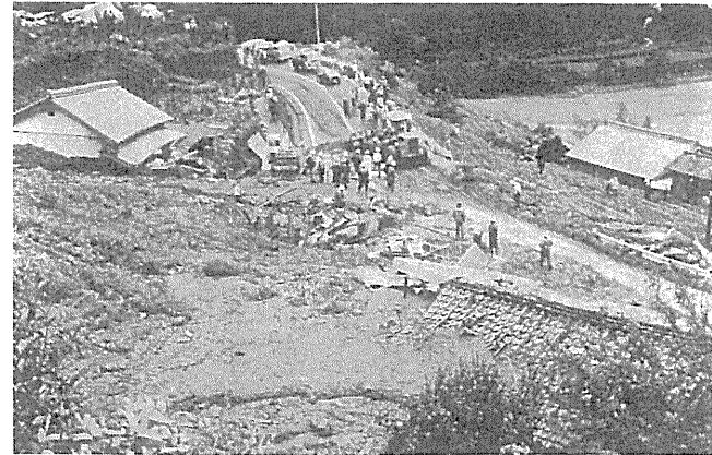
昭和50年台風5号による倉良部落の被害
