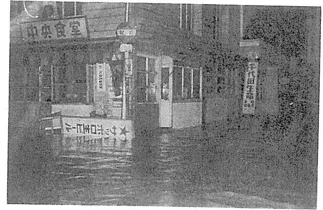
昭和38年台風9号 旧越知国バス駅前の浸水
