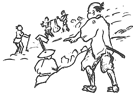
河川提防の修理
