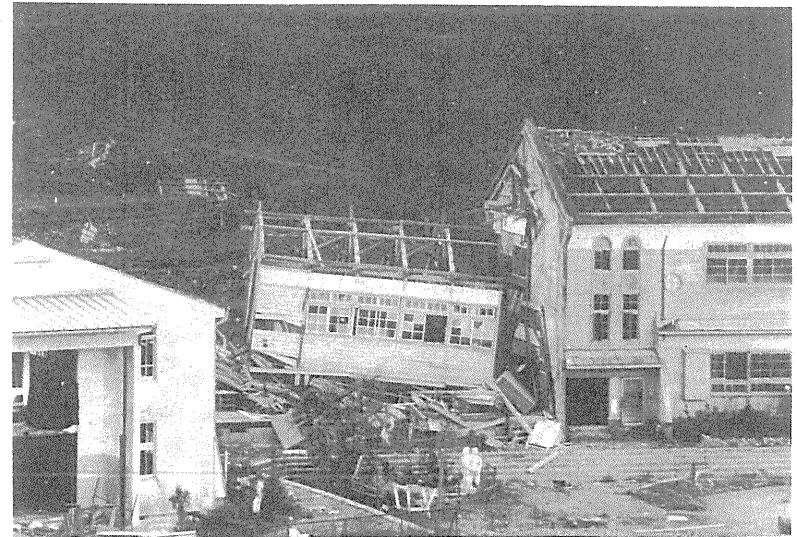
南小中学校の被害
