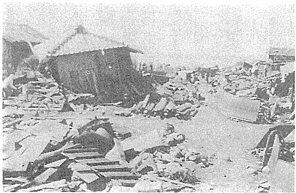
浮津下町の被害
