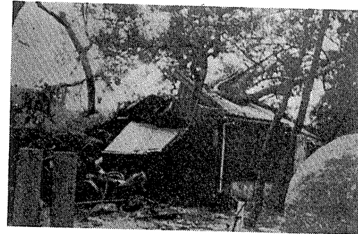
大樹の倒壊で押しつぶされた家
