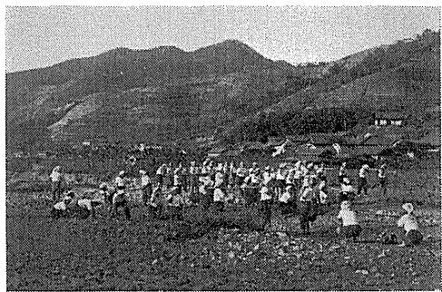
新池下付近の土砂除去作業
