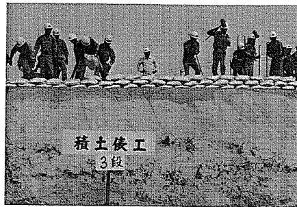
湊川堤防で越流防災のため3段積土工の訓練をしている状況
