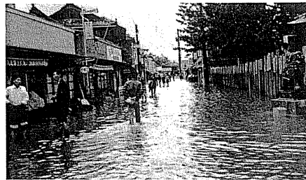
昭和36年9月18号(第2室戸)台風災害 白鳥神社前湛水の状況
