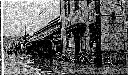
昭和36年9月18号(第2室戸)台風災害 旧白鳥郵便局前湛水の状況
