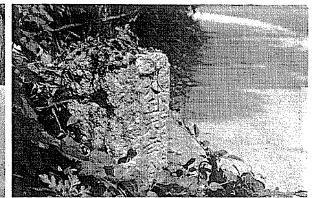
水害防止の為に作られている水門（大正6年に天王集落の東側湊川堤の上に一部の石柱が残っている。）
