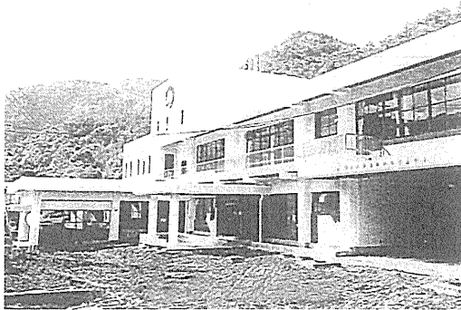
改築した現庁舎
