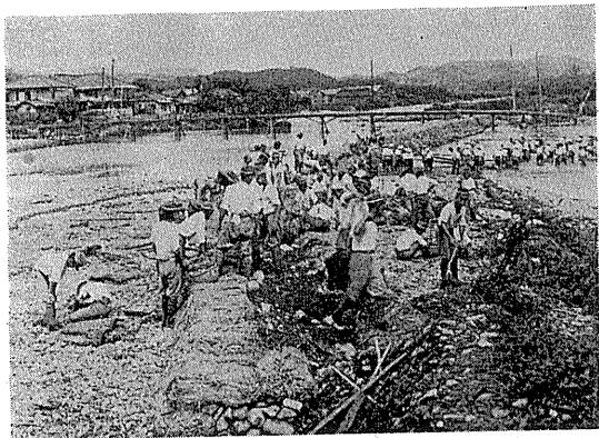
昭和18年7月、平城観栄橋付近の水害復旧作業
