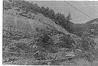
菽山崩壊(高德線及び国道11号不通)
