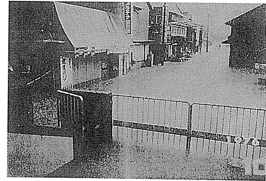
引田小学校正門前から引田駅を望む浸水状況 (9月11日)
