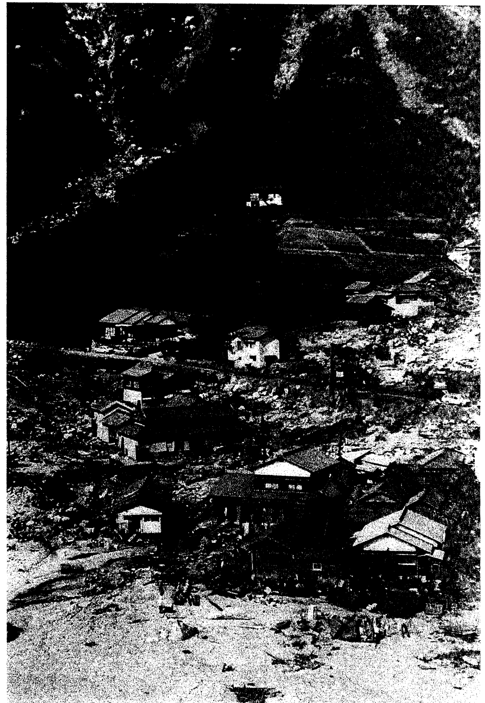
二面地区石場の土砂崩れ
