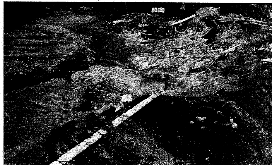
丸山付近の道路陥没
