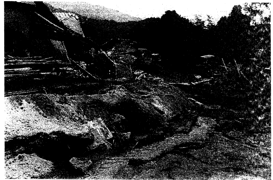
土砂で埋まった木庄川（木庄地区）
