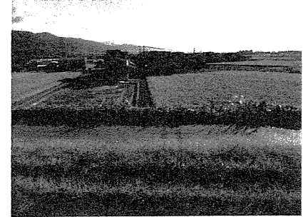
写真 2-3-2 堤防決壊箇所の現況
